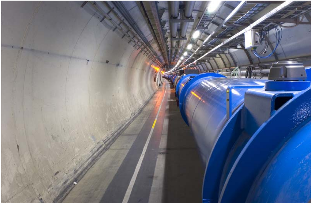
図 1.2: リング内に設置された超電導磁石
